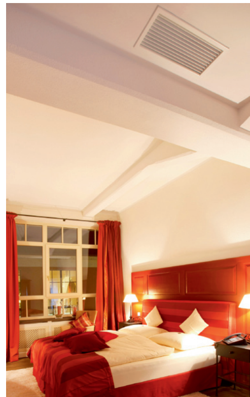
Einbaubeispiel des Zuluftgitters in der Dachschräge des Hotelzimmers (alle Abb. Mitsubishi Electric)
