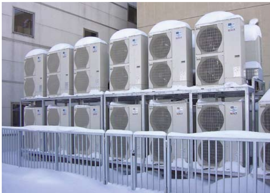
Selbst bei tiefen Außentemperaturen von -15^{\circ}\text{C} erbringen Außeneinheiten von Luft-Wärmepumpen mit Flash-Einspritzung noch 100% Heizleistung
